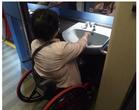
(39) 車いす対応トイレ⑥
